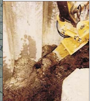
Reinigen von Spuntwänden
